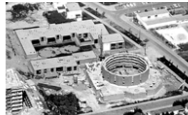
▲ Baustelle Foto: E. Koller
