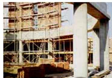
▲ Baustelle Foto: E. Koller
